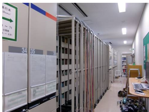
電動集密書架リプレース作業の様子
